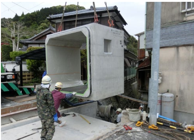
■狭小スペースでも施工が可能
