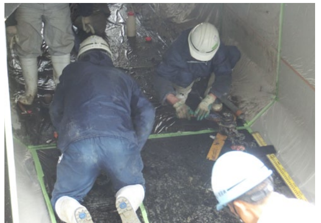
■工場にて防汚塗装を塗布 塗装を傷つけないため養生
