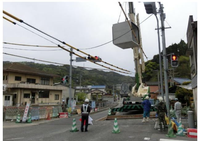
■交差点横断施工 片側通行規制で二期施工
