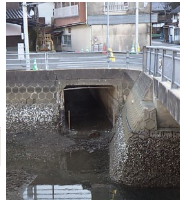
■着工前の状況
